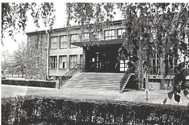
Glavna zgrada Metalurškog fakulteta
