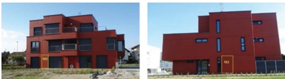
**Slika 9:** Prva primjena razvijenog fasadnog panela – Prva ECO-SANDWICH® kuća
