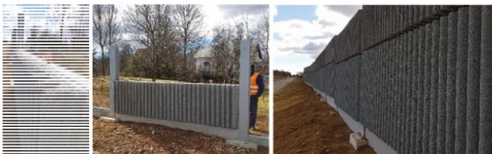
**SI 6:** Proces ugradnje panela RUCONBAR na Ličkoj pruzi
