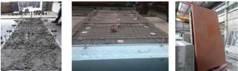
**Slika 6:** Faze proizvodnje panela u tvornici predgotovljenih elemenata
